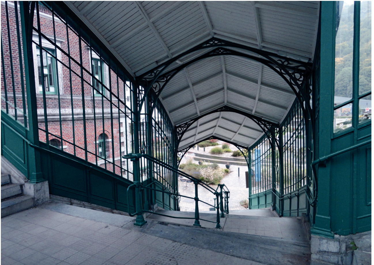
Fig. 39.- Escaliers couverts menant aux quais de la gare de Chaudfontaine établie sur un talus.
