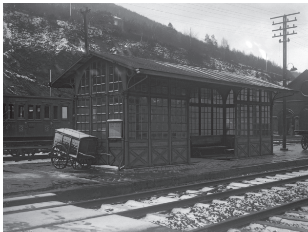
Fig. 36.- Loge-abri à Trois-Ponts (photo non datée). © Collection S.N.C.B. - Tain World Heritage.
