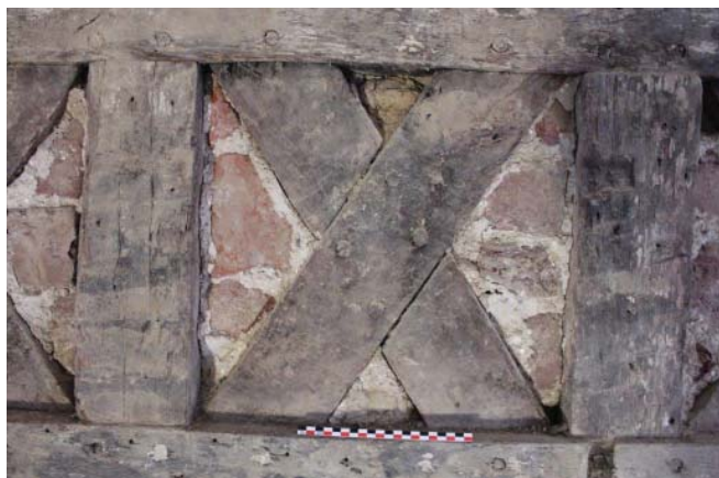
Figure 24 – Remplacement du torchis par des briques liées à la chaux.
