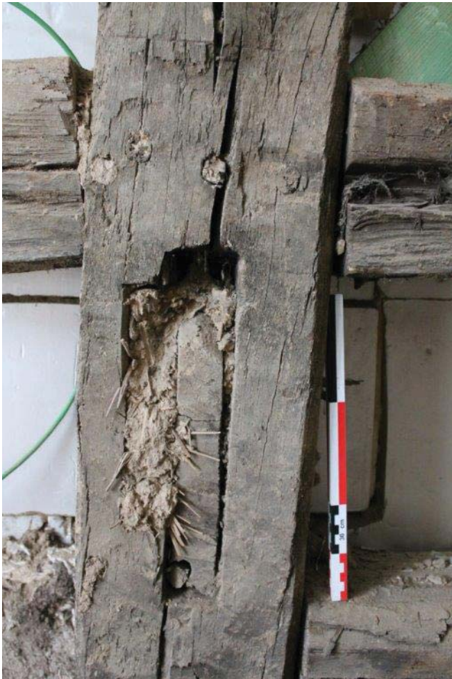
Figure 20 – Creusement d'une nouvelle mortaise au niveau du poteau IIII pour accueillir la nouvelle poutre de plancher (état 2).
