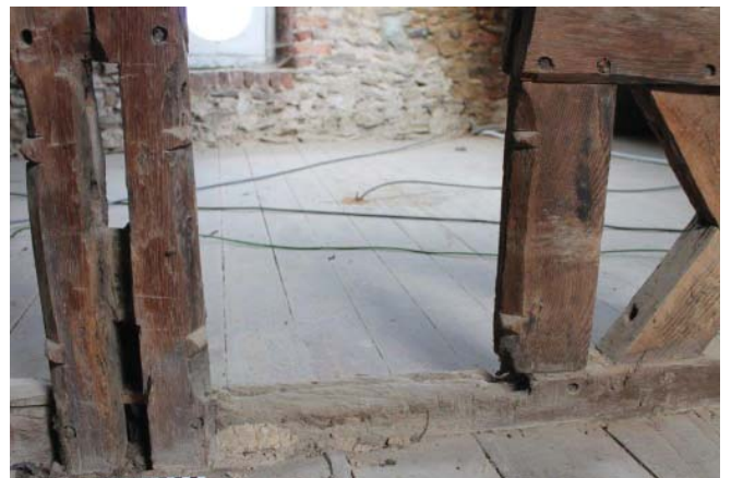
Figure 22 – Décor de la fenêtre du pan-de-bois à croix-de-Saint-André visible dans le comble de la maison n°69 (vue de l'intérieur de l'ancienne bâtisse).
