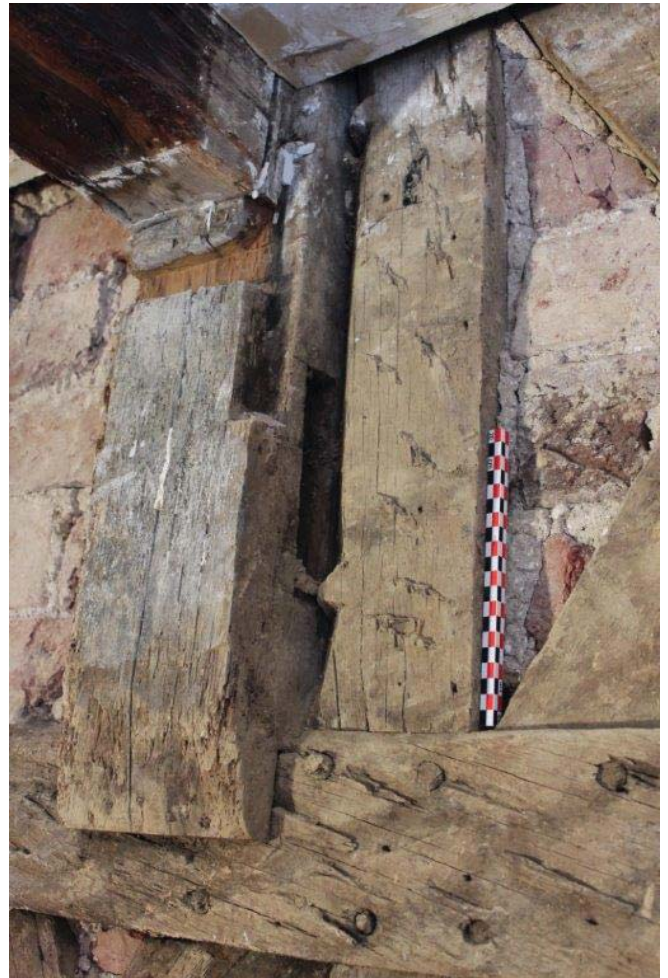
Figure 14 – Récupération d'une partie de l'entretoise IIII (marquée X) qui servait de seuil à la fenêtre orientale à l'étage du pan-de-bois primitif et réutilisée comme support de poutre de plancher dans le pan-de-bois à croix-de-Saint-André.
