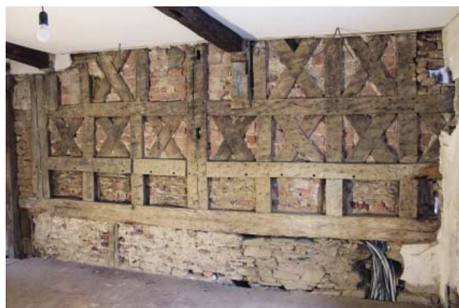
Figure 17 – Pan-de-bois à croix-de-Saint-André conservé à l'étage de la maison Dommès (vue du côté intérieur de l'ancienne bâtisse).
