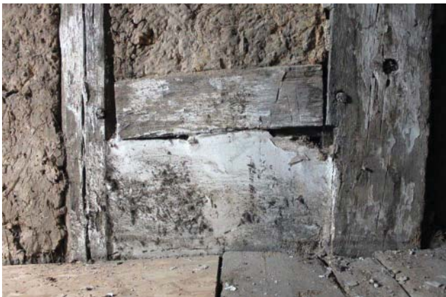
Figure 12 – Détail du linteau séparant la fenêtre occidentale de l'étage montrant la feuillure périphérique du jour inférieur. Les fenêtres seront rebouchées par du torchis recouvert d'un enduit de plâtre.
