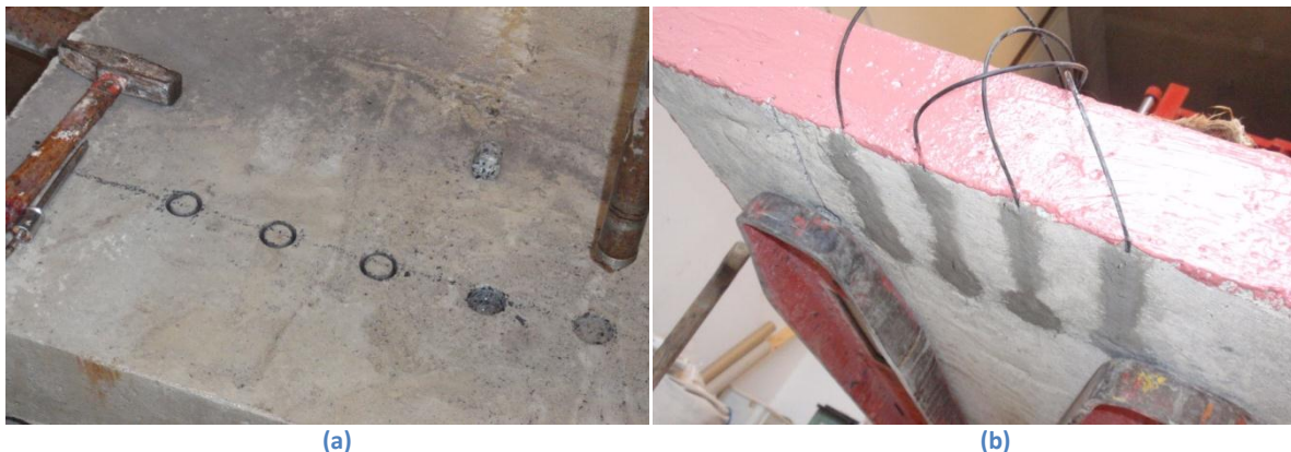
Figure 86: Réalisation des forages (a) et pose de la résine époxy sur les faces latérales des dalles (b)
