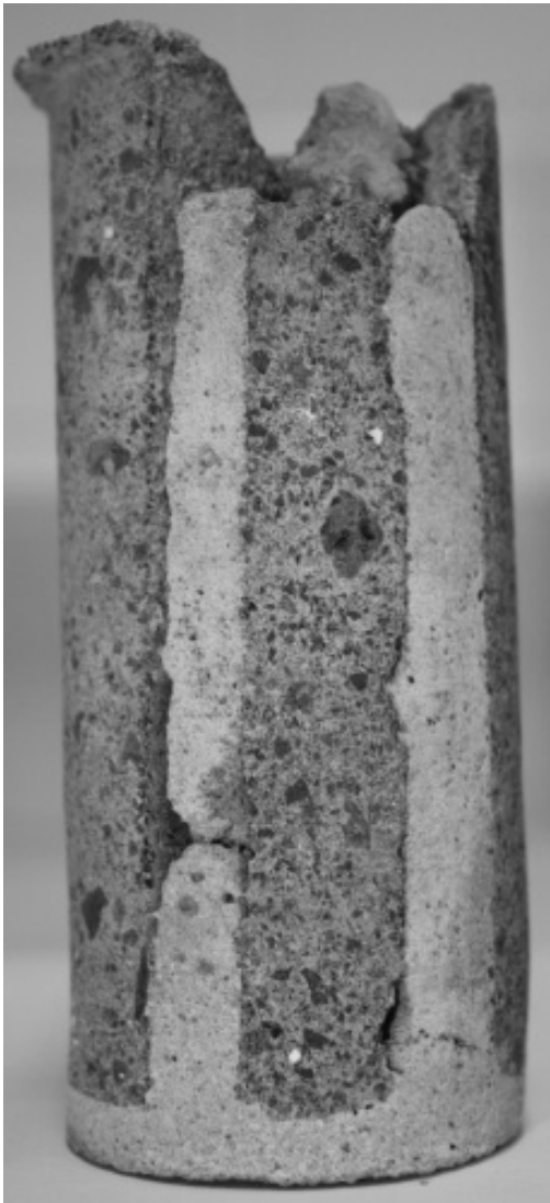
Figure 12. Échantillon en béton constituant la paroi intérieure des murs de façade, prélevé en mai 2010 à Saint-Vincent.
