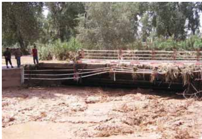
Photo 3. Rétrécissement de la section des ouvrages de traversée
