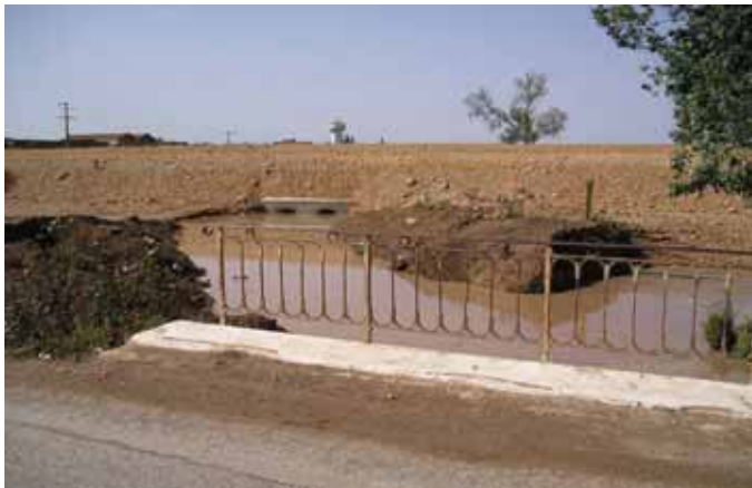
Photo 2. Endiguement par rehaussement de voies de communications
