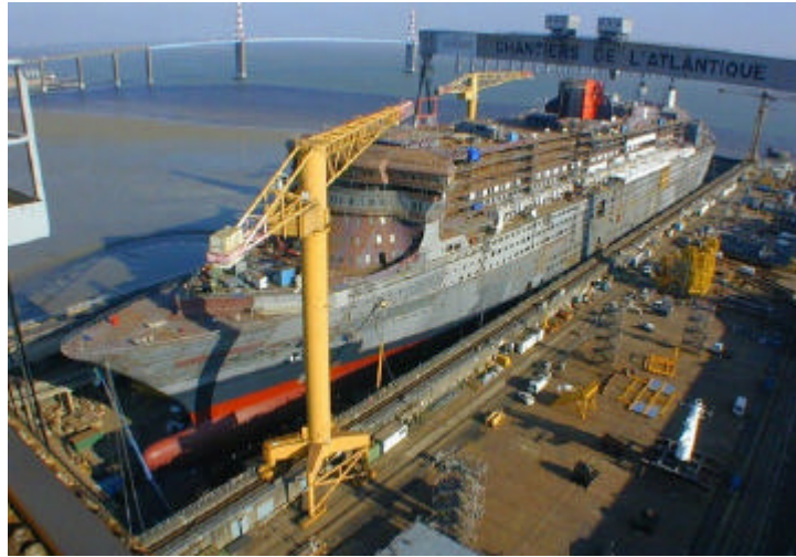
Le QM2 en cale sèche (Source photo:ALSTOM)
