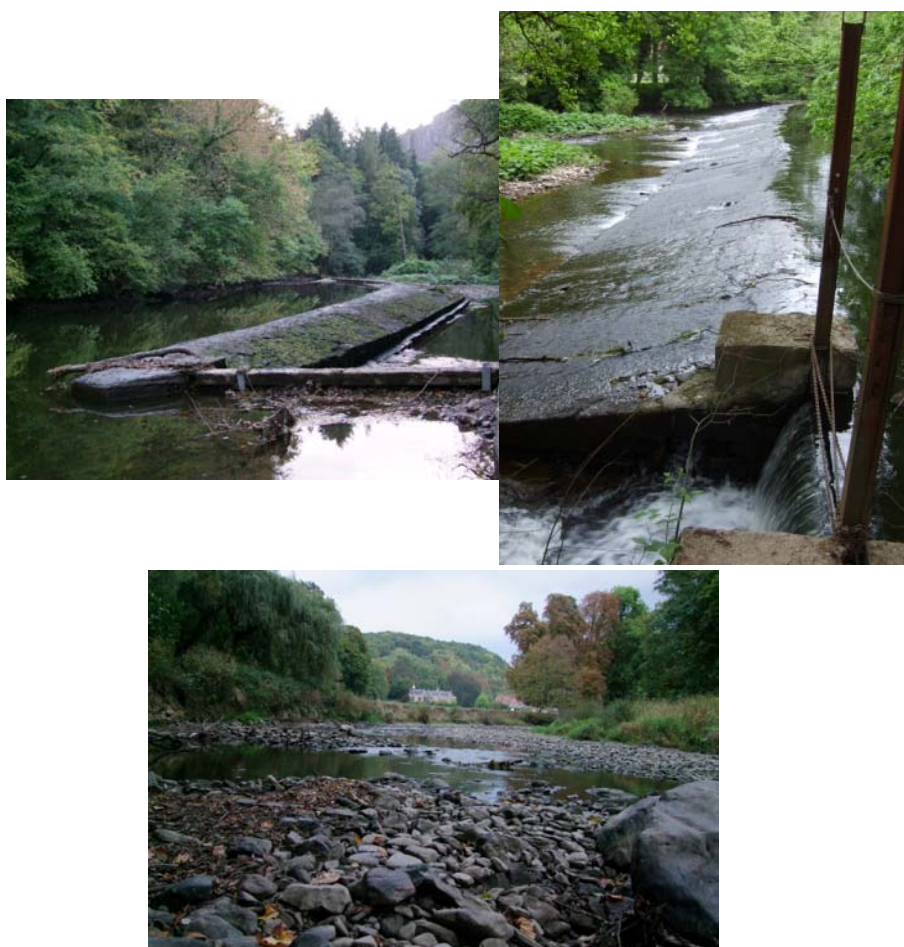
Figure 29. Illustration du court-circuitage de l'Amblève sur 0,3 km du au turbinage pendant les épisodes de bas débit, comme ici le 30 septembre 2009 (3,050 m 3 /s). Source des photos : Contrat de rivière de l'Amblève.
