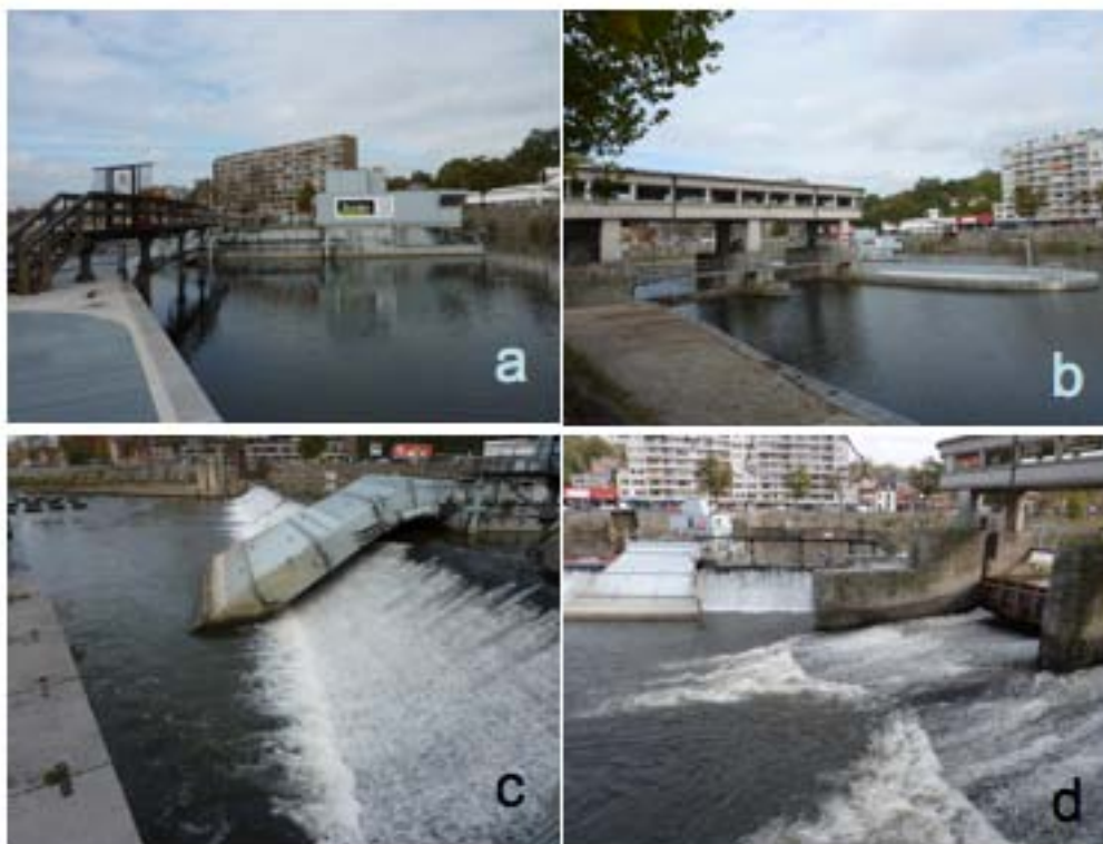
Figure 22. Vues sous différents angles de la centrale hydroélectrique flottante OMEGA au barrage des Grosses Battes sur l'Ourthe à Angleur dans la situation de 2010 après la construction de la nouvelle échelle à poissons à bassins pour la remontée. (a) Vue vers la rive droite depuis l'échelle à poissons ; (b) Vue depuis la rive gauche montrant, à l'avant -plan, les vannes levantes de régulation du niveau d'eau, au milieu, l'échelle à poissons à bassins recouverte d'un caillebotis et, à l'arrière-plan, la centrale flottante OMEGA appuyée contre le barrage ; (c) Vue de la restitution de l'eau turbinée en aval du barrage et à proximité du courant d'eau de sortie de l'échelle à poissons ; (d) L'écoulement de l'eau sous les vannes levantes.
