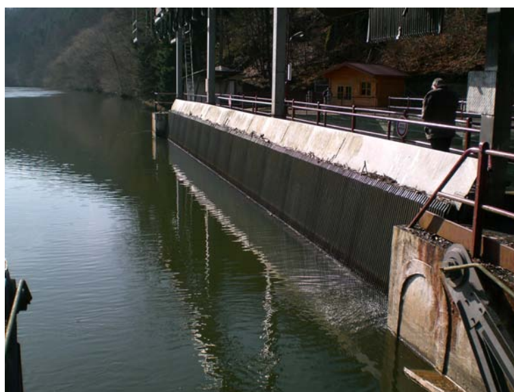
Figure 37. Les infrastructures de turbinage au complexe hydroélectrique de Lorcé/Heid de Goreux. Au-dessus à gauche : les turbines Francis de 12 et 14 m 3 /s. Au-dessus à droite : la turbine Francis de 3 m 3 /s alimentée par le débit réservé au barrage de Lorcé. En-dessous : la grille de protection de la prise d'eau latérale dans l'Amblève.
