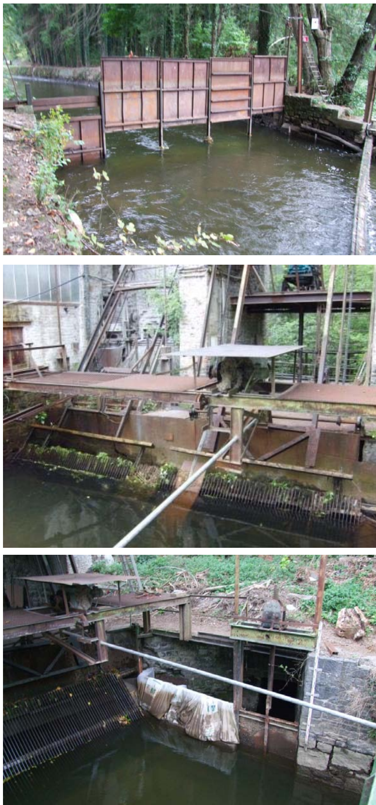
Figure 28. Vues de la prise d'eau de la centrale hydroélectrique de Raborive sur l'Amblève. Au-dessus : entrée du canal d'amenée équipée de vannes ; au milieu : grille de protection des turbines ; en-dessous : canal latéral avec vanne qui pourrait être aménagé en exutoire de dévalaison comme à Mérytherm. Source des photos : Contrat de Rivière Amblève.
