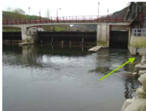
Situation depuis 2007 avec nouvelle échelle à poissons
