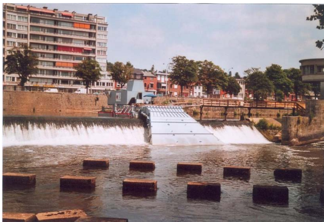
Figure 21. Vues par l'aval du site du barrage des Grosses Battes sur l'Ourthe à Angleur montrant (au-dessus) l'ancienne centrale hydroélectrique fonctionnelle de 1985 à 1998 et (en-dessous) la nouvelle centrale flottante en siphon (OMEGA) entrée en service en 2005.
