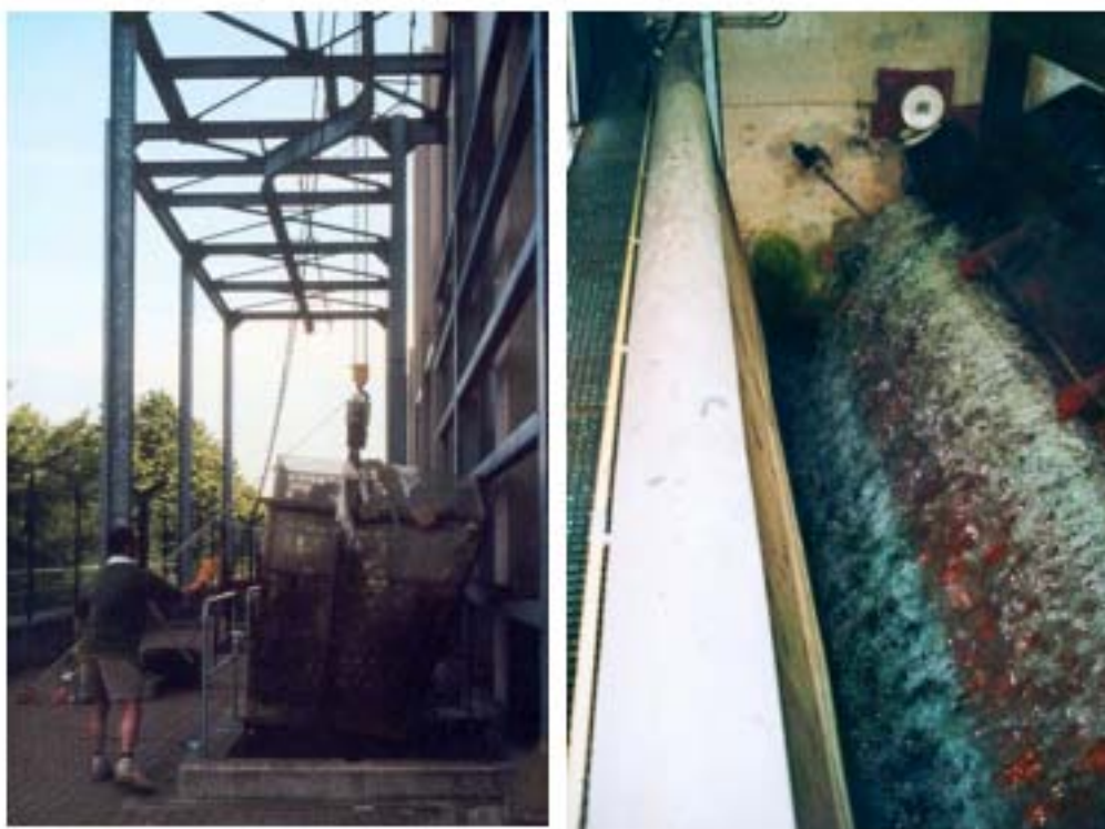
Figure 14. A droite : dégrillage des débris et des poissons accumulés sur les grilles d'un dégrilleur. A gauche : relevage, pour contrôle des poissons, du conteneur recevant les produits récoltés sur les deux dégrilleurs et la récolte de la pompe à poissons couplée à un tambour filtrant.
