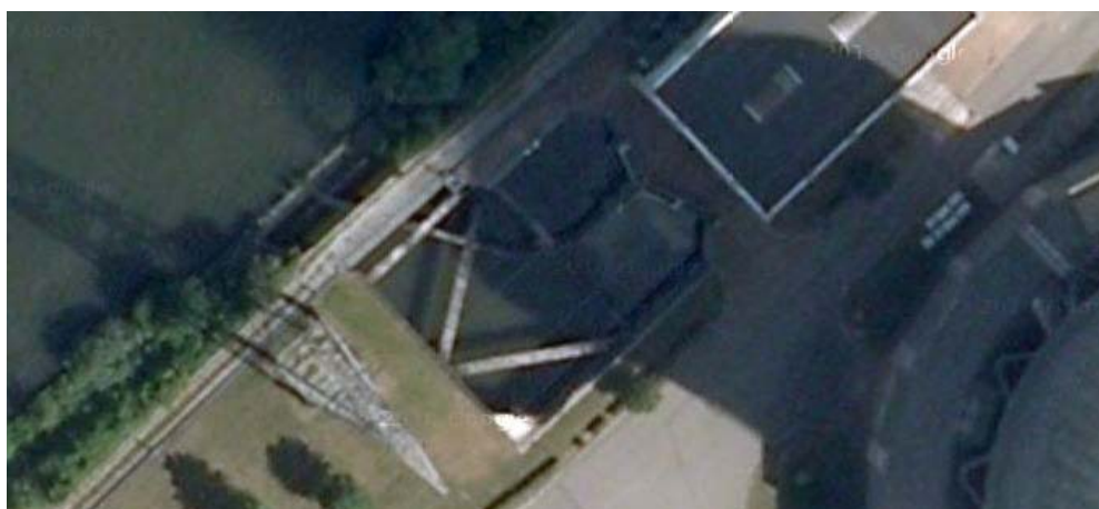
Figure 13. Au-dessus : Schéma de la prise d'eau de refroidissement de la centrale TGV de Seraing sur la Meuse et du dispositif de 'pompe à poissons' couplée à un tambour filtrant (Philippart et al., 2003). En-dessous : vue aérienne de la prise d'eau (source : Google Map).
