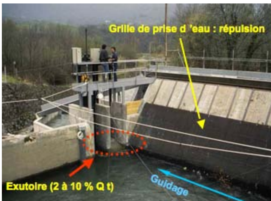
Figure 30. Exemple d'une prise d'eau hydroélectrique protégée par une grille à barreaux peu espacés complétée par un exutoire latéral de dévalaison pour les jeunes saumons (Larinier et Travade, 2009).
