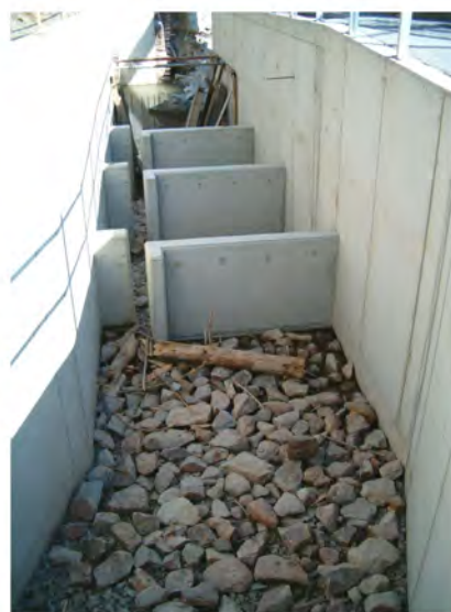
Planche photos 2: Vue du barrage de Lorcé et des bassins de l'échelle à poissons avant sa mise sous eau. On voit le substrat de fond qui devrait permettre aux petites espèces benthiques d'utiliser la passe.
