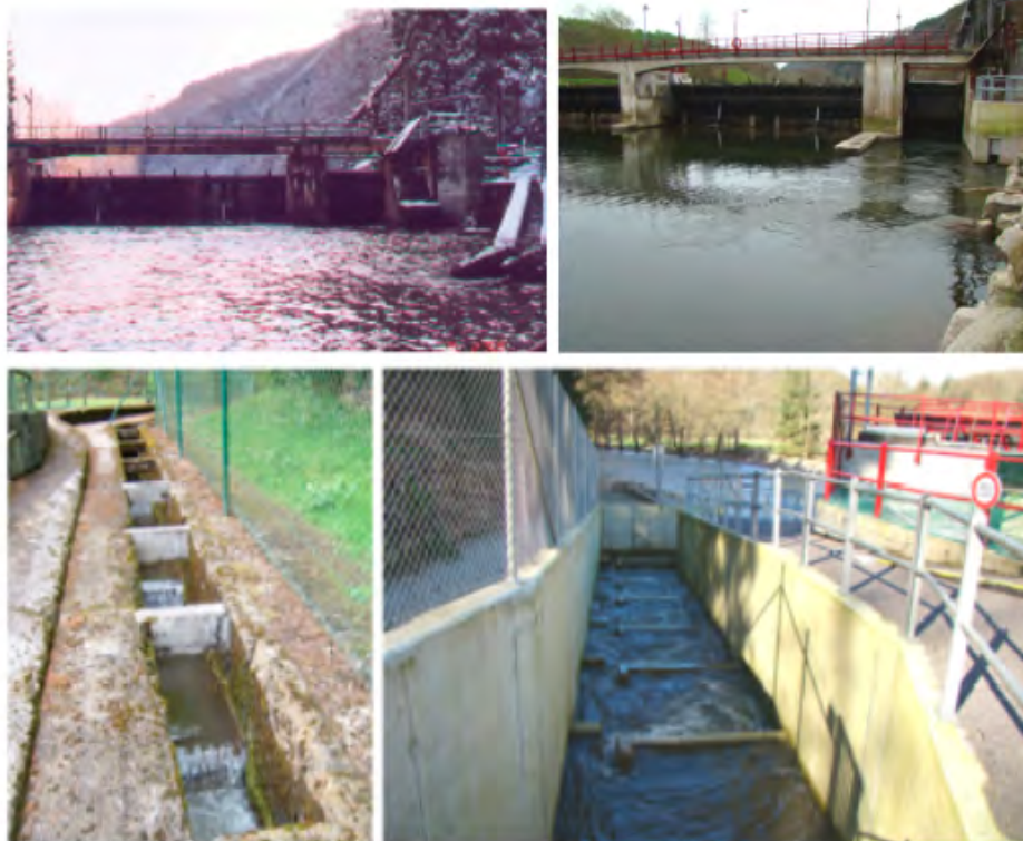
Planche photos 1: Vue de l'ancienne échelle à poissons construite en 1932 (gauche) et de la nouvelle échelle à poissons construite en 2007 (droite). Le débit à l'intérieur de l'échelle actuelle est de 500l/s.
