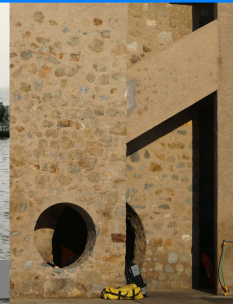
Construction du port de STARESO
