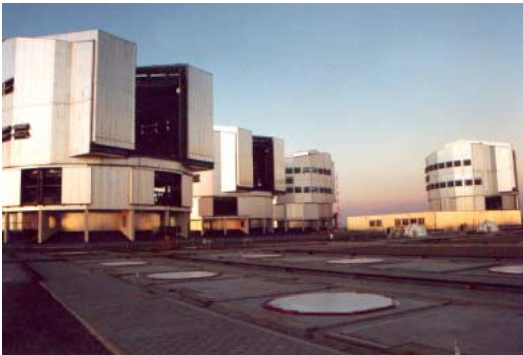
Vue générale des quatre « coupôles » du VLT, avec en avant-plan les emplacements réservés aux futurs télescopes auxiliaires AT.
