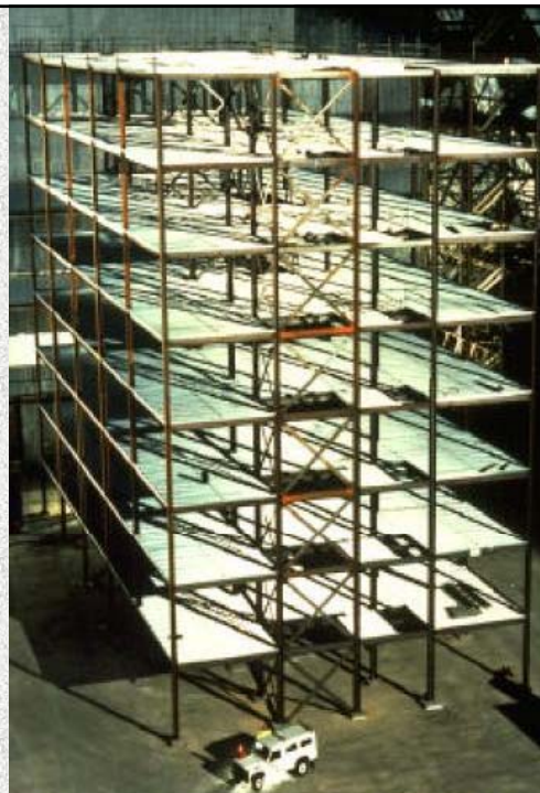
Bâtiment mixte acier béton Cardington - UK
