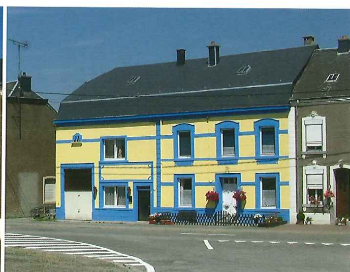
▼ Teintes acidulées d'une façade récemment restaurée.
