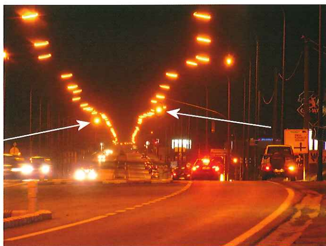
Neuville-en-Condroz, route du Condroz : la profusion de sources lumineuses (plus de 100 sources de lumière visibles sur la photo !) éblouit les conducteurs et induit de la confusion – les feux sont oranges (flèches) et vont passer au rouge : ils sont presque invisibles !
