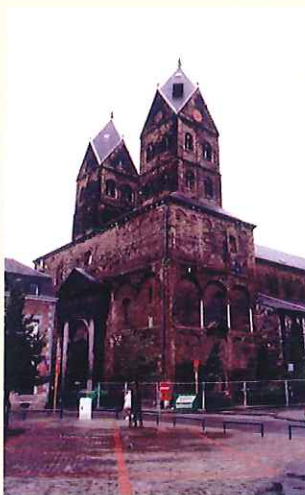
▼ Façade sud de l'avant-corps avant 1998.
