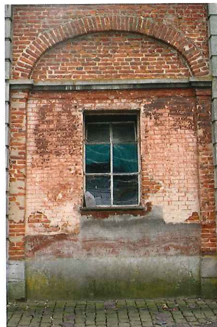
▲ 12. Thoricourt, cour d'honneur du château, détail d'une remise à voitures.
