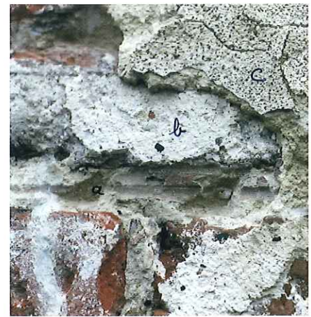
▲ Maison des Ingénieurs, façade extérieure, partie gauche : stratigraphie des trois premiers traitements : a : traces des joints d'origine, tirés a fresco et rougis ; b : restes du premier enduit ; c : 2 e enduit. Photo T. Cortembos, © MRW Dgatlp.
