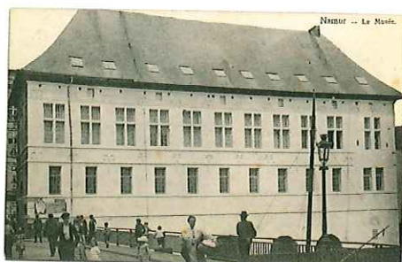
▲▶ Namur, halle aux viandes. Cet exemple classique d'architecture "Renaissance mosane", briques et calcaires de Meuse sous toiture d'ardoises violettes, était jadis blanchi, sur soubassement goudronné - ce qui modifiait évidemment la perception des vides et des pleins d'une façon radicale.
