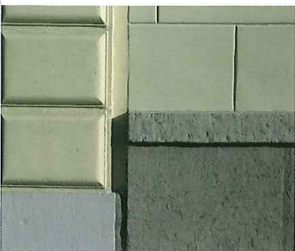
▲ Rue Perdue, façades néoclassiques avec enduit clair et pierre peinte (pour partie). Harmonie typique de la deuxième moitié du XIX e siècle.
