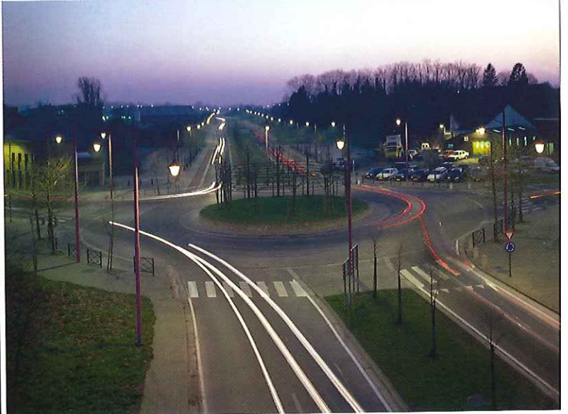
▲ Contournement de Ath. Le but poursuivi par l'aménagement d'un rond-point est d'accroître la sécurité des automobilistes en les obligeant à ralentir, tout en leur assurant un passage fluide du carrefour. Un bon éclairage permet d'attirer l'attention des automobilistes sur la configuration du carrefour et de leur assurer un bon guidage visuel.
