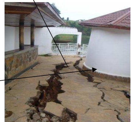
Fig. 10c: Tassements différentiels d'une paillote de l'hôtel la Roche (Source : Kashinzwe, 2009)
