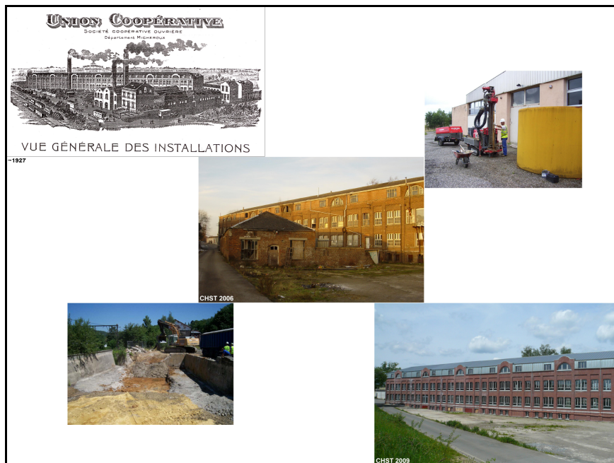
Fig. 1 : Illustration du processus d'assainissement d'un site d'activité économique désaffecté – Site dit « Société Générale Coopérative » à Soumagne (Réf. DGO4 – LG199). En haut à gauche : vue générale des installations vers 1927 (pleine activité) ; au centre : vue des installations à l'abandon en 2006 ; en haut à droite : illustration d'une campagne de prélèvement de sol ; en bas à gauche : illustration d'un assainissement par excavation ; en bas à droite : situation en 2009, situation après assainissement et rénovation de l'enveloppe extérieure.
