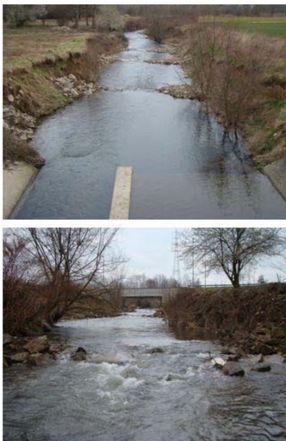
Figure 10. Site de la Berwinne à hauteur d'un passage sous routier à Moelingen : (au-dessus) rendu aisément franchissable en remontée par toutes les espèces de poissons et (en-dessous) dans la situation antérieure à la réalisation de l'aménagement
