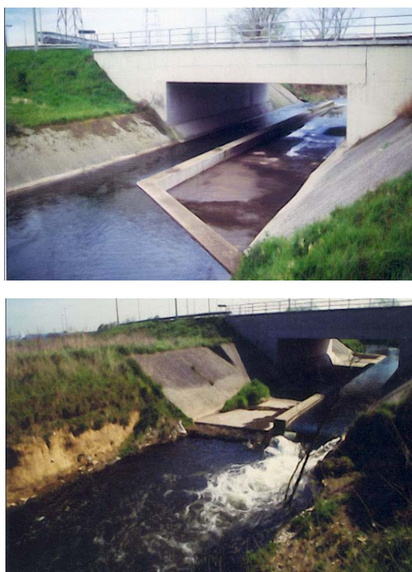
Figure 10. Site de la Berwinne à hauteur d'un passage sous routier à Moelingen : (au-dessus) rendu aisément franchissable en remontée par toutes les espèces de poissons et (en-dessous) dans la situation antérieure à la réalisation de l'aménagement
