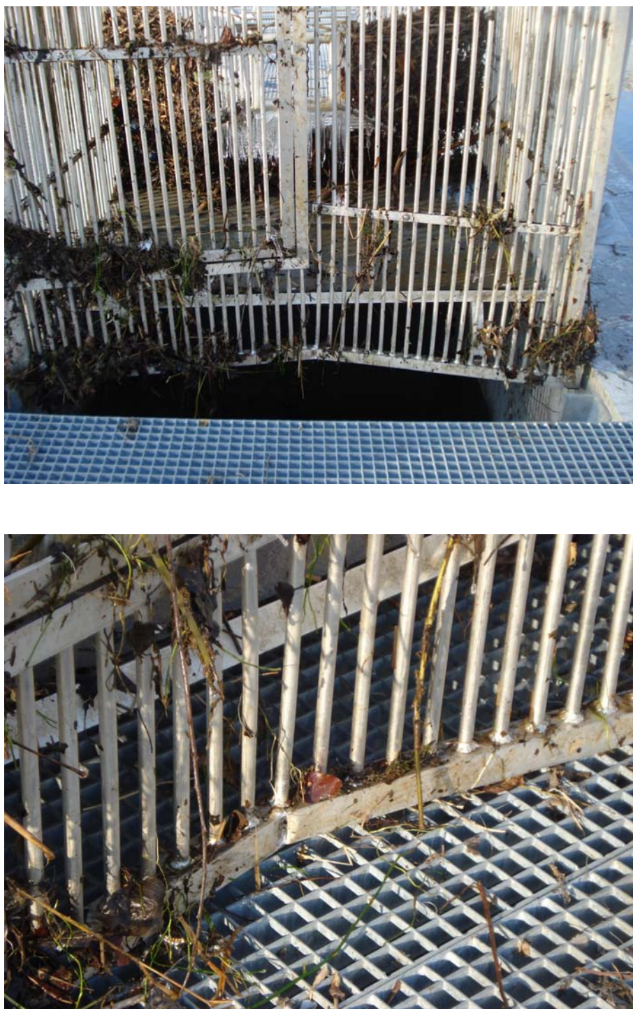
Figure 7. Déformations de la cage de capture causées par la pression de l'eau sur la couche de débris qui colmatent les barreaux en fin d'année.
