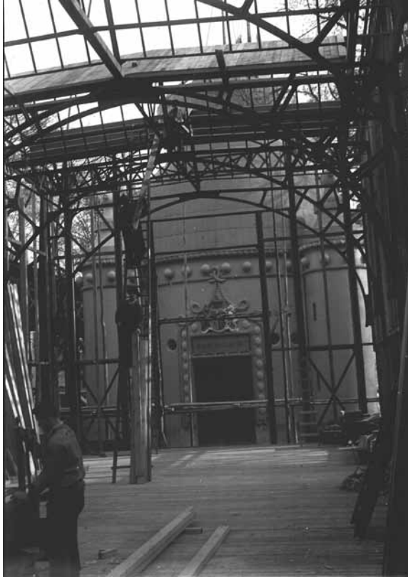
Ill. 3 : Vue de la structure métallique en construction, Paris, 1900, © CRMSF.
