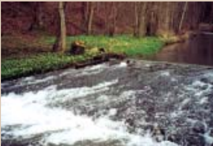
Un barrage du Néblon (à Ouffet) franchissable par les truites et les ombres.
