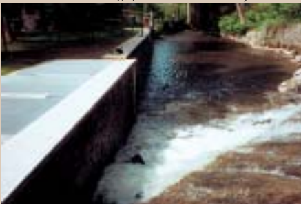
Un barrage de l'Aisne (à Bomal) difficilement franchissable qui a été équipé en 1995 d'une échelle à poissons à bassins successifs (visible sur la gauche).
