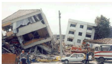
Figure 10.15. Effet de la formation de «rotules plastiques» en tête des poteaux du rez de chaussée. (Boumerdes, Algérie, 2003 - Kocaeli, Turquie, 1999)
