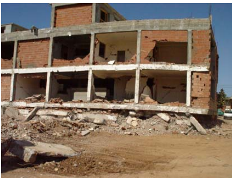
Figure 10.15. Effet de la formation de «rotules plastiques» en tête des poteaux du rez de chaussée. (Boumerdes, Algérie, 2003 - Kocaeli, Turquie, 1999)
