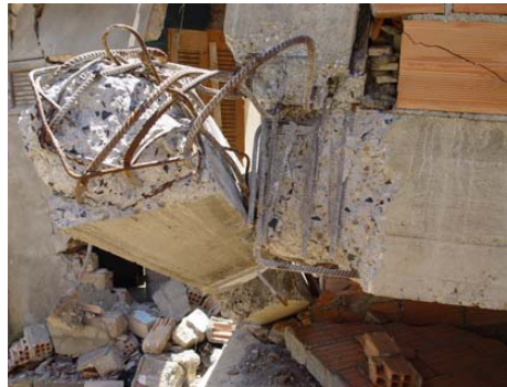
Figure 10.26. Absence d'armature transversale au nœud. Effondrement dû à cette absence au nœud et dans la zone critique du poteau.
