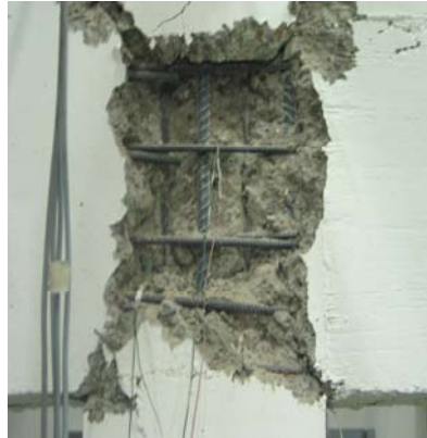
Figure 10.24. Sollicitation de cisaillement du nœud poteau-poutre. Figure 10.25. Etat Limite Ultime d'un nœud correctement armé dans une situation « poutre forte - poteau faible ».
