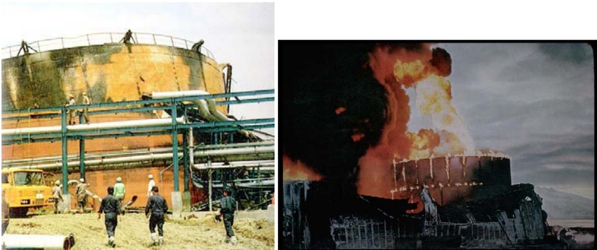
*Figure 16.3. Quelques effets des séismes sur les réservoirs : « elephant foot », chutes, fuites et incendies.*
