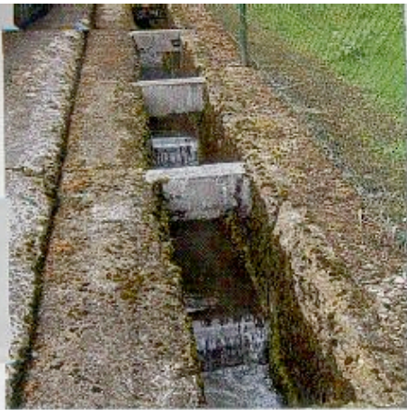
Vue de l'ancienne passe à poissons qui était installée au barrage de Lorcé avant 2007.
