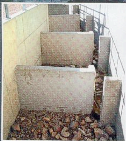
Vue du barrage de Lorcé et des bassins de l'échelle à poissons avant sa mise sous eau. On voit le substrat de fond qui devrait permettre aux petites espèces benthiques d'utiliser la passe.
