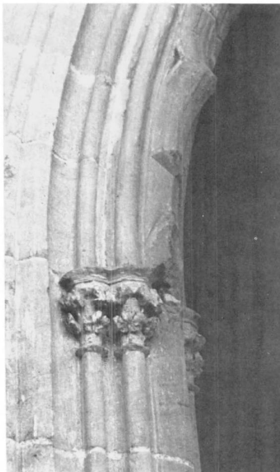
Fig. 14. — Détail des colonnettes de la fenêtre gothique de la salle du chapitre.
