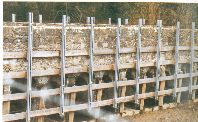
1 Pont barrage de Montignies Saint-Christophe : pose des carcans avant les travaux.
