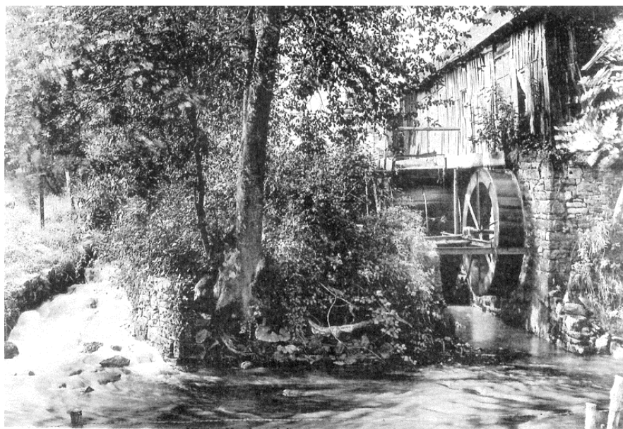
Figure 12 : Roue à augets de l'ancienne scierie de Ninane (Heyd) implantée sur le même site qu'un ancien haut-fourneau (Carte postale ancienne, s.d.)
