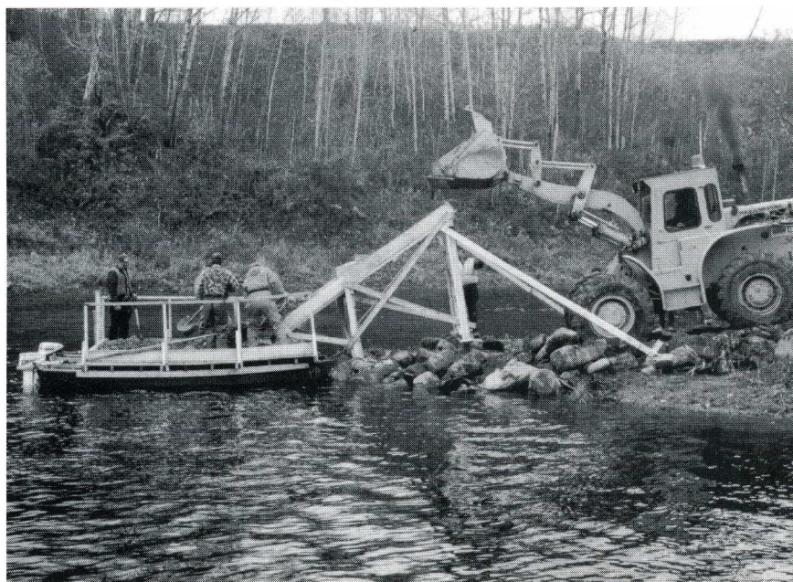
Photo 7. Aménagement d'une frayère à saumon atlantique au Québec-Canada. (Photos [6 et 7] de l'auteur)
