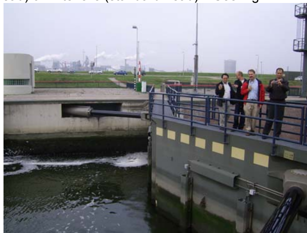
Fig. 14 : Reverse Mitre Gates (IJmuiden-NL)
