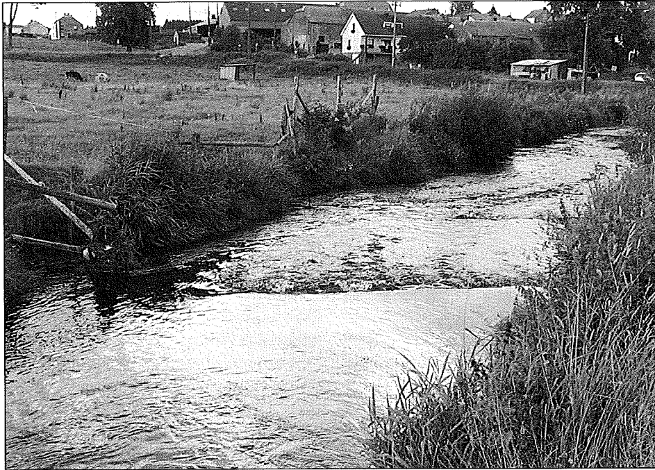
Figure 10: Photo du tronçon réaménagé de l'Ourthe à Moiricy. Abbildung 10: Foto des verbauten Abschnittes der Ourthe bei Moiricy.
