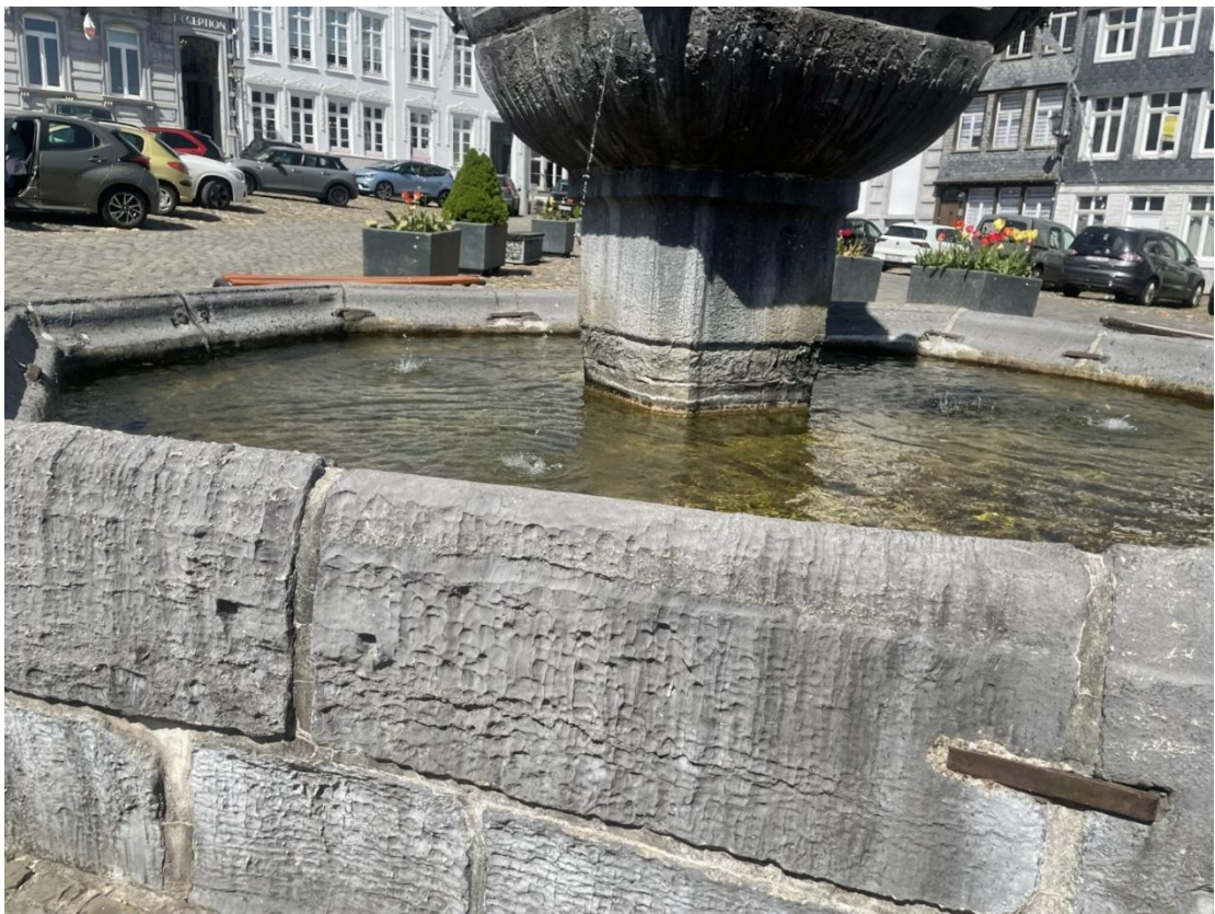
Figure 15. Détail des micro-lapiez sur la margelle calcaire du bassin de la fontaine du perron de Stavelot.
