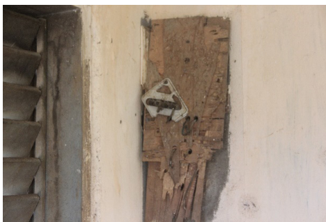
Pose compteur avec les fils électriques
