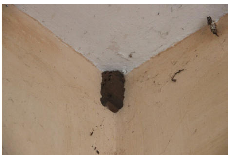
Intérieur du bâtiment de la radio
