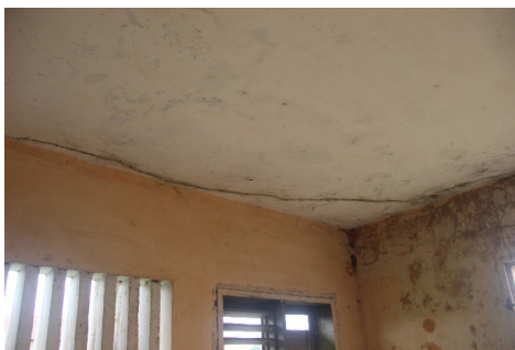
Intérieur du bâtiment de la radio
