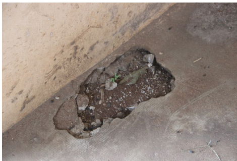
Etat de l'intérieur du bâtiment
