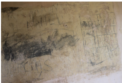
Intérieur du bâtiment de la radio
