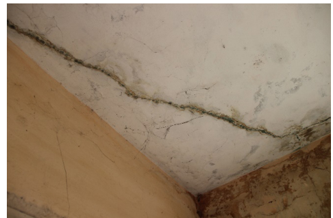
Apparition de mousse à l'intérieur du bâtiment (absorption d'eau, gonflement et dilatation de la ferraille du béton)
