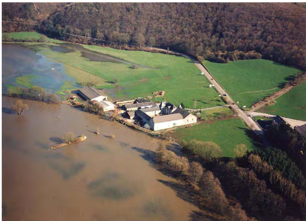
Figure 8-6 : Photographie aérienne - étendue de la zone inondée au droit de la ferme située directement en aval de la station d'épuration 61
