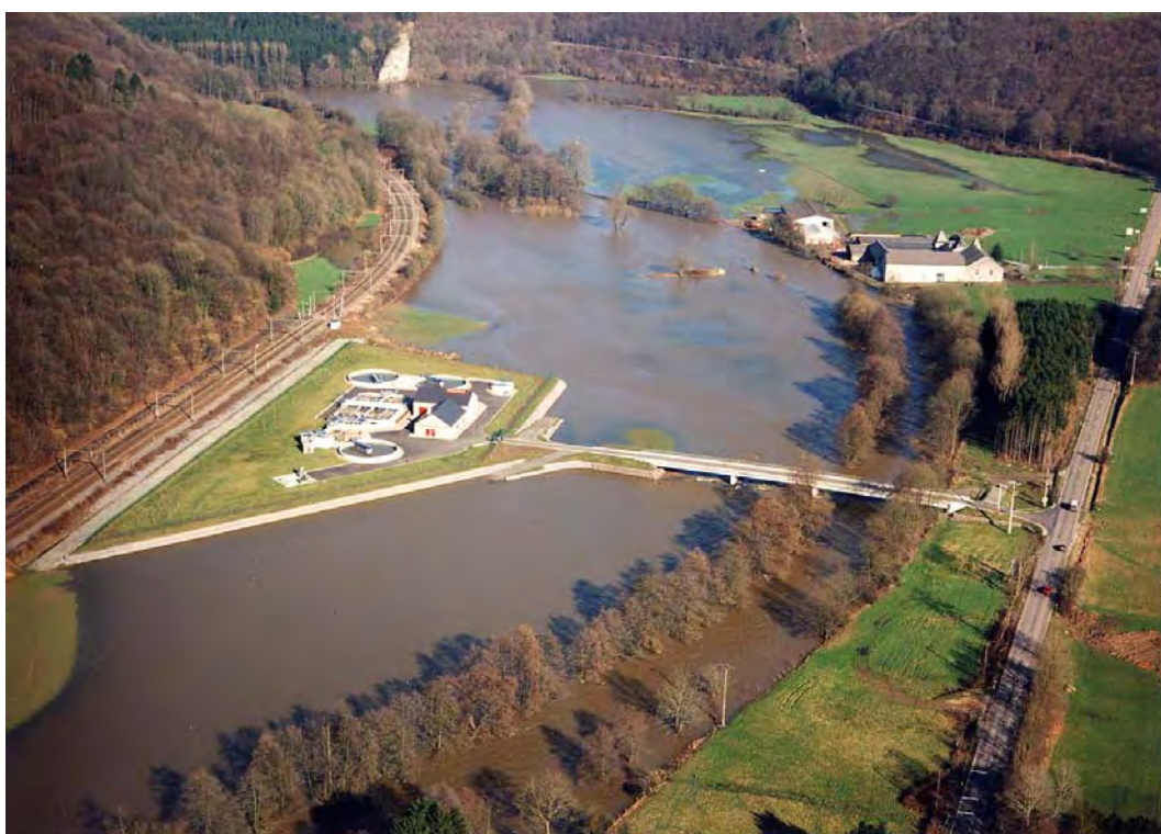
Figure 8-5 : Photographie aérienne - détails de la station d'épuration 60
