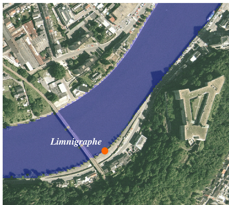
Figure 7-58 Situation du limnigraph du SETHY à Huy, coord. Lambert (211387,134350) Altitude de référence : 68,001 m
