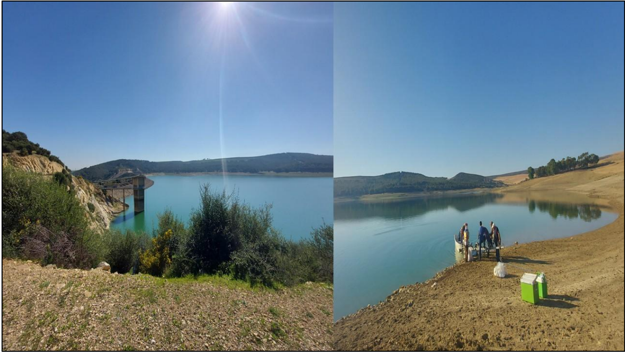
Figure 14: Photographies du barrage de Joumine : (a) tour de prise et (b) la retenue du barrage de Joumine en 2021
