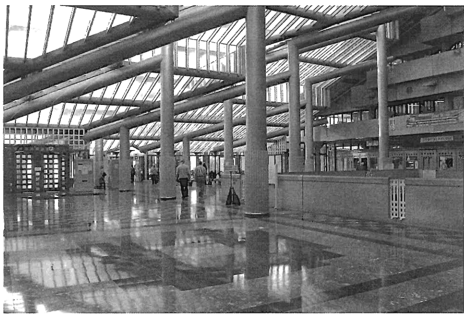
Université de Liège, Sart Tilman. Le CHU, l'un des bâtiments universitaires liégeois conçus par Charles Vandenhove, de 1962 à 1986, fait référence à des configurations géométriques élémentaires dans une tradition classique revisitée.
