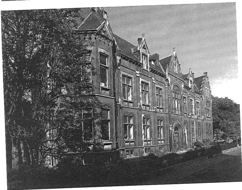
Université de Liège, bâtiment du quai Van Beneden, depuis l'ouest. L'Institut de Zoologie (1882) dû à l'architecte Lambert Noppus (1827-1889) a été réalisé dans le style néo-classique qu'il maîtrisait parfaitement.
