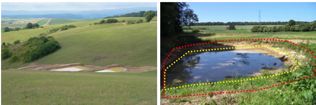
Figure 27 : Mares tampons aménagées le long d'un axe de ruissellement (à gauche ; © Michal Kravčík) et délimitation d'une zone tampon (jaune-rouge) autour d'une marre permanente (à droite ; © SPW).
