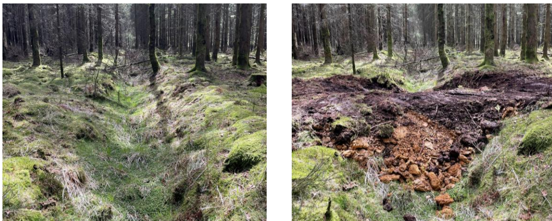
Figure 31 : Photos avant (à gauche) et après (à droite) bouchage de réseau de drains. © Lucas Goosens.
