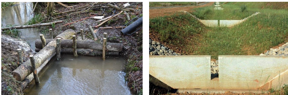
Figure 33 : Représentation de systèmes de redents dans un chenal : à gauche, une barrière en bois imitant les barrages des castors (© The Hadlow Estate, site internet), à droite, une succession de redents en béton (© l'eau, l'industrie, les nuisances, site internet).
