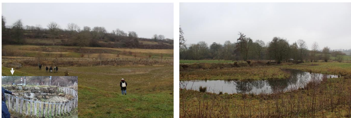
Figure 28 : Zone de rétention avec ajutage (à gauche) et zone de rétention avec reméandration d'un cours d'eau (à droite). © ULiège-GxABT.
