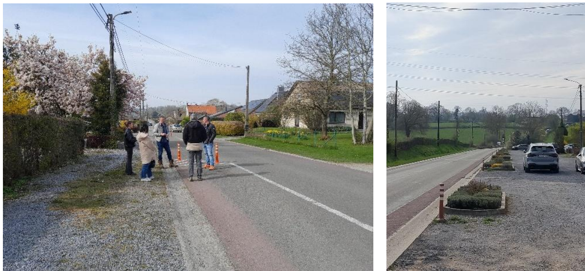
Figure 50 : Visite de terrain à Manaihan-Ourcy pour les aménagements en voirie. A gauche ; emplacement d'un futur ralentisseur et noue sur la Thier Martin. A droite : les 6 bacs à fleurs de la commune convertibles en noue pour la rue de Manaihan.
