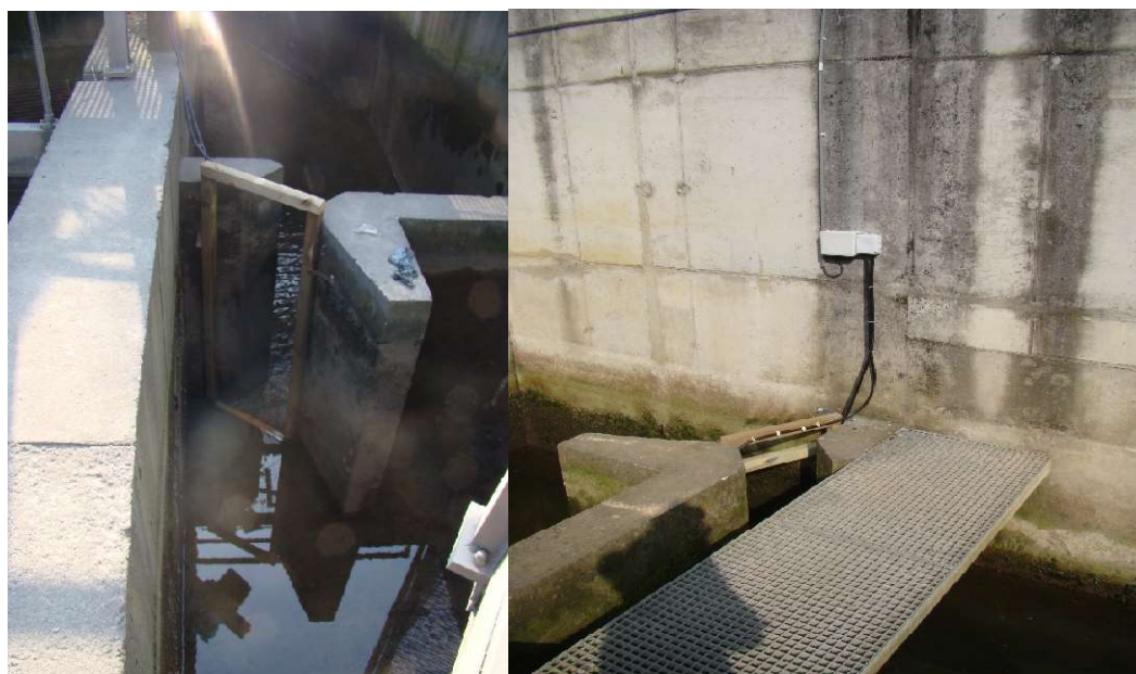
Fig. 5 : Photo de l'antenne de détection RFID placée au niveau de la dernière échancrure de la passe à poissons de Monsin (à gauche) et celle installée en 2015 dans la partie aval de l'échelle à poissons (à droite).
