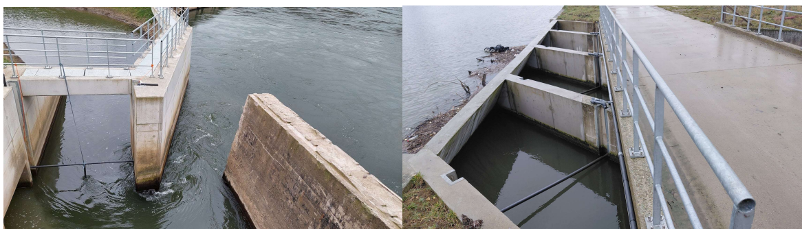
Figure 8 : Antennes de détection RFID au niveau de la rivière de contournement du barrage d'Ampsin sur la Meuse (aval à gauche, amont à droite).
