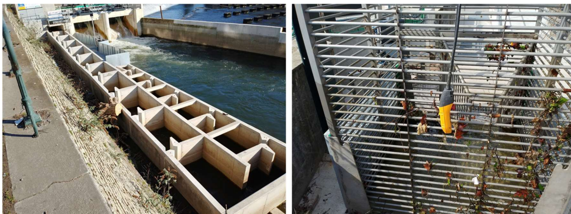
Fig.9 : Vue aval de la nouvelle passe à poissons installées en rive droite (à gauche) et photo de la cage de capture installée dans le bassin le plus en amont (à droite).
