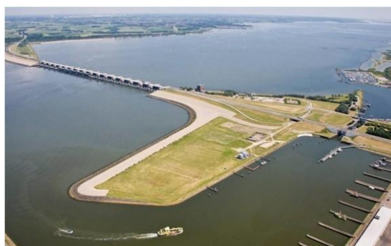
Barrage anti-tempête Haringvliet du delta du Rhin et de la Meuse
