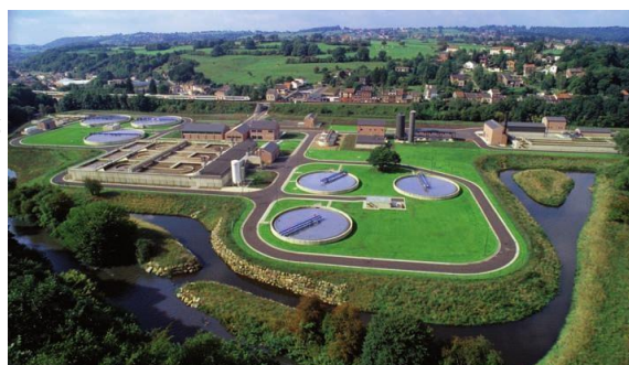
Station d'épuration de la Vesdre à Wégnez
