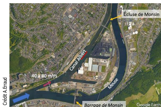
Complexe du barrage de Monsin et du canal Albert
