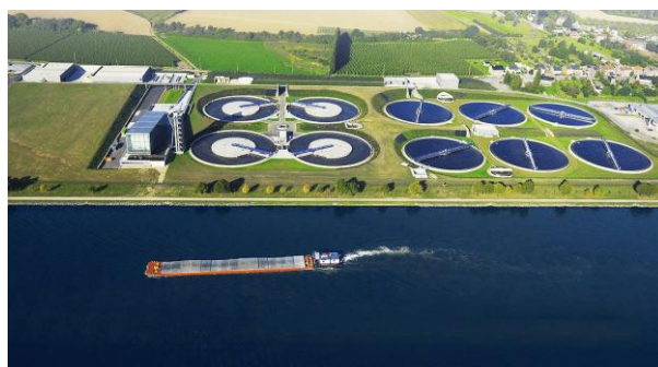
Station d'épuration de Oupeye
