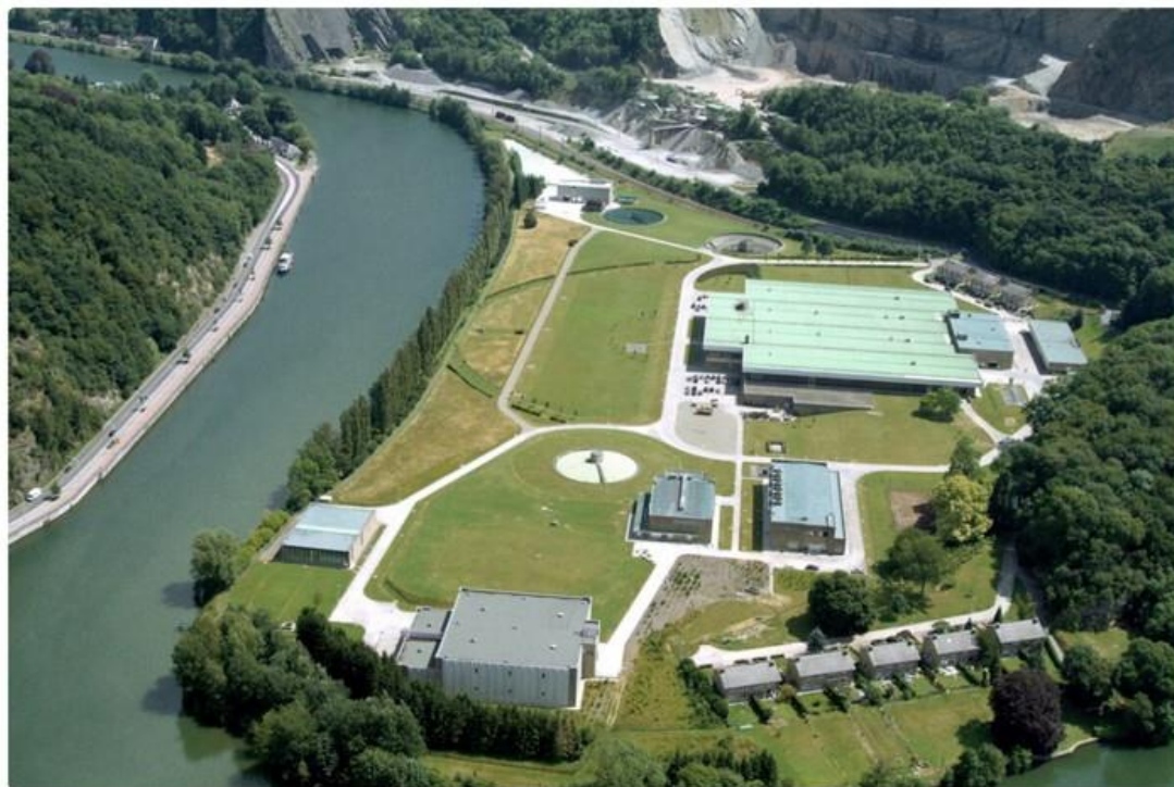
La station de Tailfer de Profondeville transforme l'eau de la Meuse en eau potable. ©ÉdA - 60666112155
