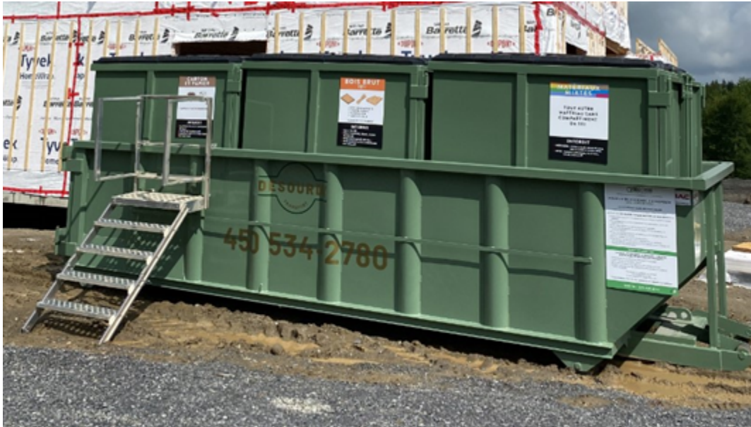
Figure 23 : Installation d'un conteneur compartimenté et de la signalétique associée
