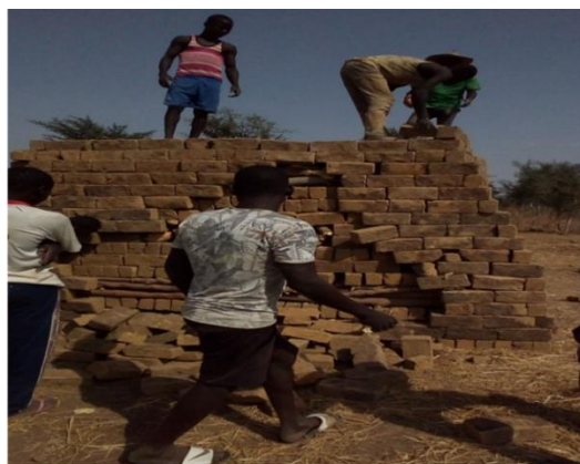
Figure 4.7 : Des jeunes producteurs en plein montage d'un four de 10 000 briques, dans une approche de mutualisation des efforts. Source : Idrissou Mounpe, Enquête de terrain, Yagoua, mars 2021.
