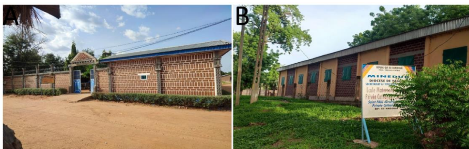
Figure 4.5 : Deux établissements hybrides et esthétiques construits dans deux quartiers de Yagoua, dans une approche d'hybridation complexe. Source : Idrissou Mounpe, Enquête de terrain, juin 2023, Yagoua.
