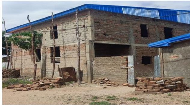
Figure 4.1 : Bâtiment construit par Bernard (un enseignant de l'enseignement technique) usant de l'autoconstruction solidaire. Source : Idrissou Mounpe, Enquête de terrain, mai 2023, Pitoa.
