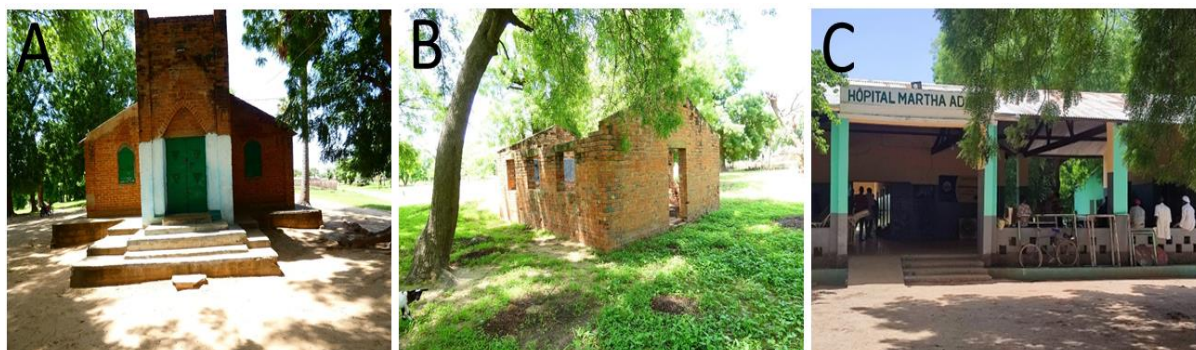
Figure 3.1 : Image de l'église Fraternelle Luthérienne de Yagoua (A) ; Vestiges de l'école construite par les missionnaires américains (B) ; Hôpital Martha Adaire laissé par les missionnaires (C). Source : Idrissou Mounpe, Enquête de terrain mai 2023 à Yagoua.
