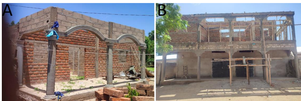
Figure 4.4 : Deux bâtiments hybrides construits dans le noyau urbain de Yagoua, dans une approche d'hybridation complexe. Source : Idrissou Mounpe, Enquête de terrain, juin 2023, Yagoua.
