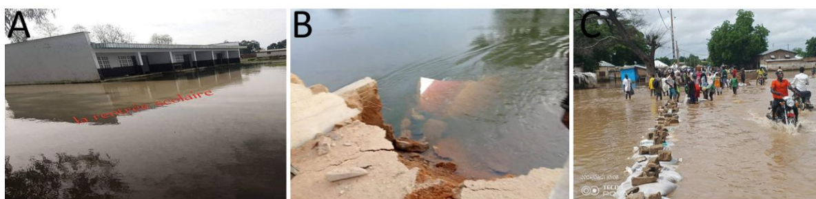
Figure 5.1 : Une école inondée (A) ; une maison d'habitation inondée qui a fini par céder à la pression de l'eau (B) puis la construction d'une diguette de circonstance par les populations en vue de ralentir la pression des eaux (C). Source : Idrissou Mounpe, Enquête de terrain, Yagoua (quartier Kaskao), septembre 2024.
