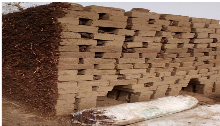
Figure 1.1 : Image d'un four nomade en cours de montage pour la cuisson des briques. Source : Idrissou Mounpe. Enquête de terrain, Yagoua, mars 2021.
