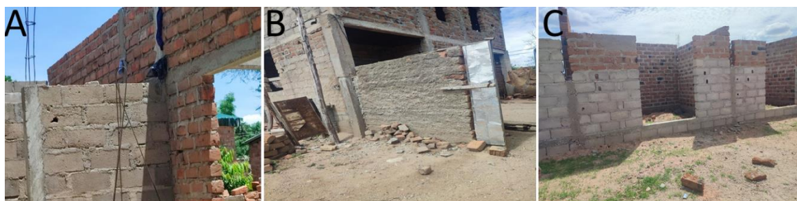
Figure 4.6 : Une maison hybride en chantier avec murs extérieurs en brique de terre cuite et ceux intérieurs en parpaing (image A) ; deux maisons hybrides en chantier avec des murs extérieurs panachés (image B) et une préférence/velléité pour l'élévation de la façade en parpaing (C). Source : Idrissou Mounpe, Enquête de terrain, Yagoua juillet 2023, et Pitoa juin 2023
