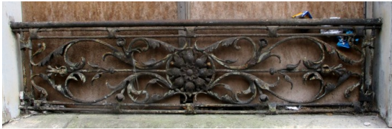
Galerie d'appui du rez de chaussée
