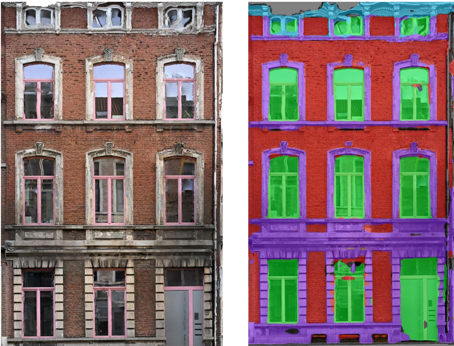
Façade Saint Laurent
