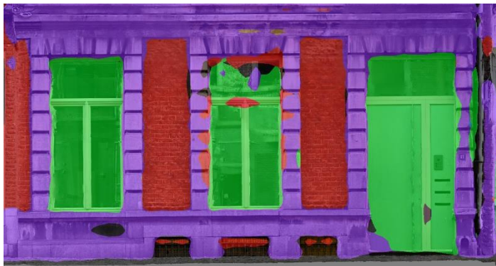
Façade Saint Laurent
