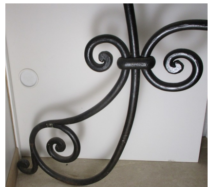
Fixation des courbes : le même système est utilisé pour la grille de la fenêtre (à gauche) et pour une table (à droite) réalisée par Henri Metzmacher.
