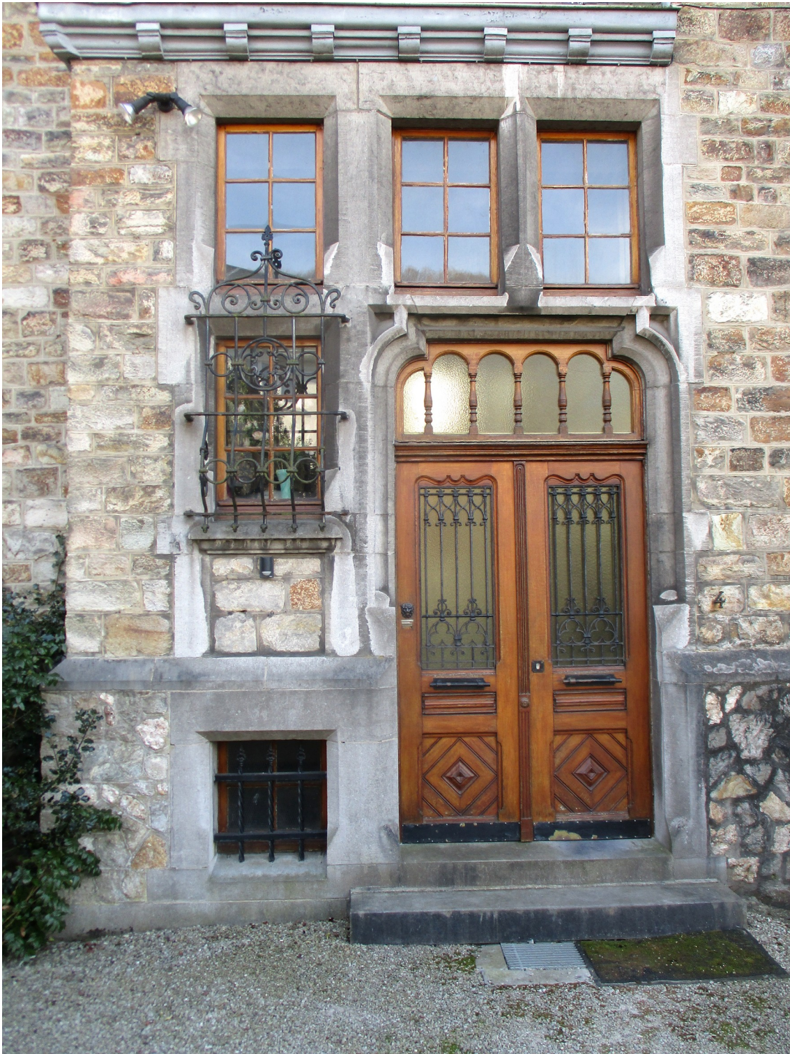
Porte d'entrée et fenêtre (avec grilles de protection)
