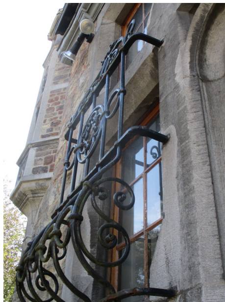
Grille de protection de la fenêtre : divers types d'assemblage
