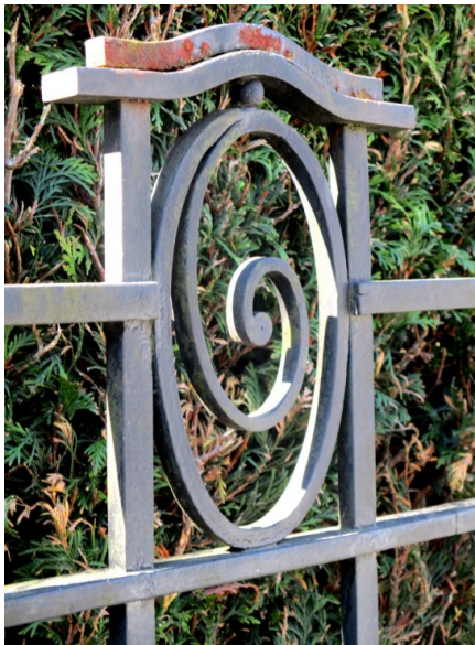
Ornementation de la grille : exemples de soudure autogène. A gauche : ovale et et bille d'espacement ; à droite : spirale dans un carré.
