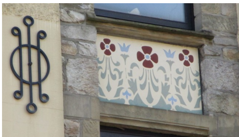
Pièce ouvragée en fer de soutien et panneau décoratif.
