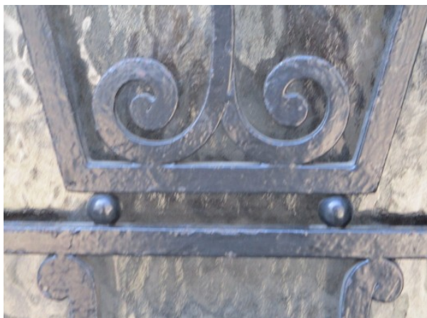
Porte d'entrée (partie inférieure) Utilisation de billes d'espacement. Il en va de même dans la partie supérieure de cette porte.
