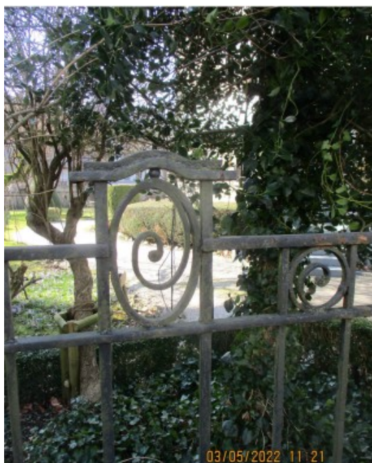
Ornementation de la grille du jardin Exemple de soudure autogène et bille d'espacement Ce type de grille limite aussi la propriété voisine.
