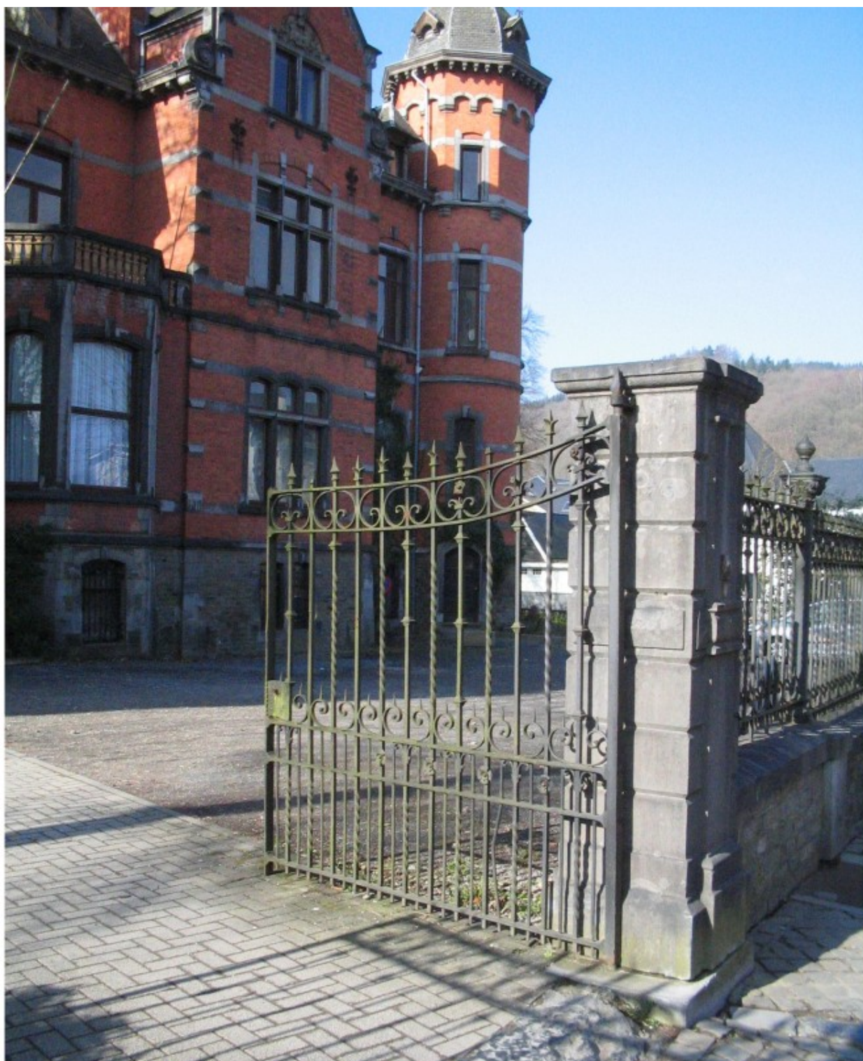
Grille d'entrée principale de la Villa Steisel
