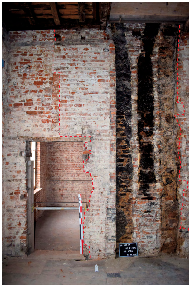
Fig. 1 Vestiges d'une cheminée engagée (pointillés) partiellement comblée pour le percement d'une baie de porte entre le n° 81 et le n° 83 rue Haute (Bruxelles), 83.1.1.N.13, cliché de F. Van Boxem (© urban.brussels - ULiège).
