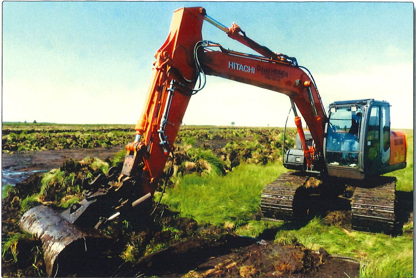
Les projets LIFE ont consacré la possibilité d'utiliser désormais de puissants engins chenillés capables de travailler efficacement dans les terrains les plus fragiles. (Ph. Roger Herman).
