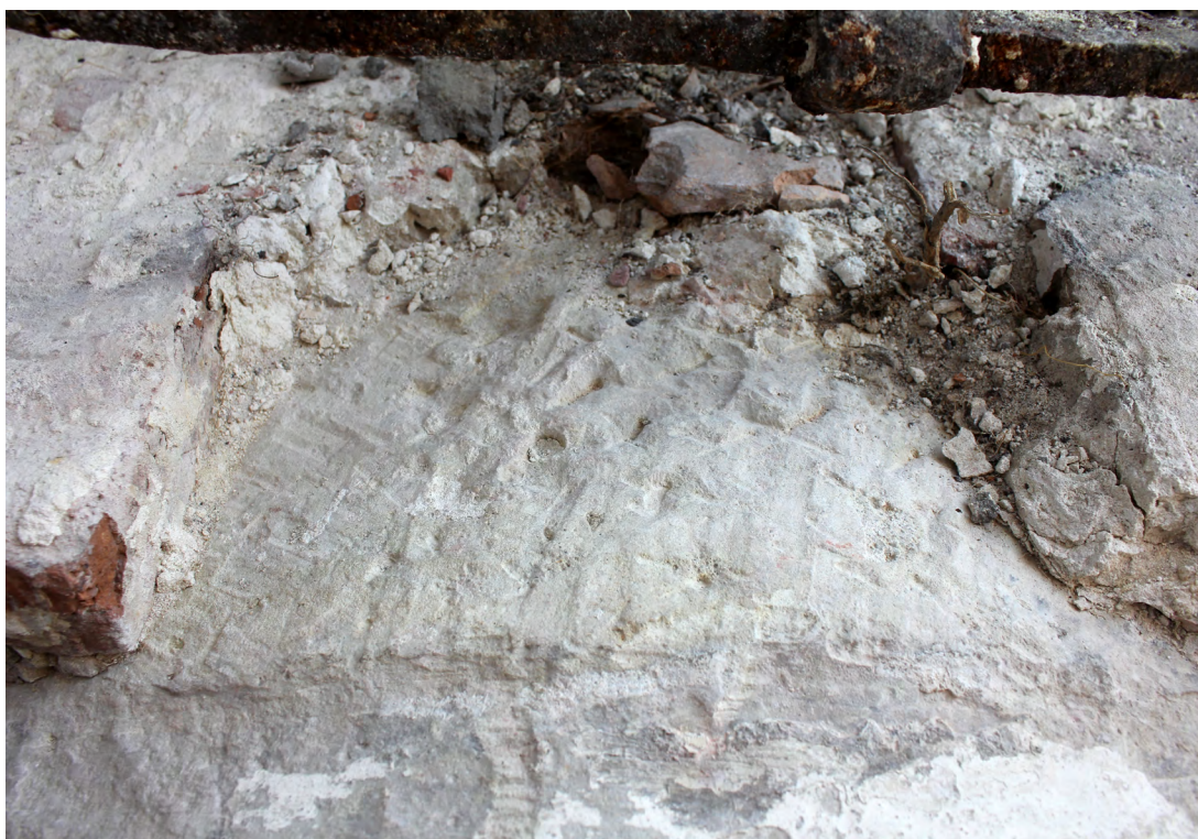
Fig. 1 Rue du Marché aux Herbes n° 82 à Bruxelles, traces de dégrossissage à la broche/pointe sur l'extrados d'un des deux oculi de la façade. © urban.brussels – ULiège.
