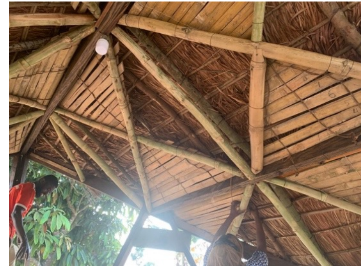
Pose par les étudiants M1 et assistante, des éléments de faux plafond en latte de bambou sur les gîtes en bambou.
