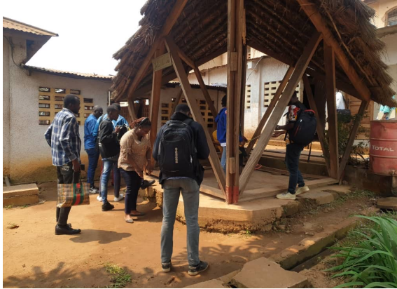
Rétrospection sur la paillote, constats sur l'état de lieu avec les étudiants de M1, les encadreurs et l'assistante Arlette Matsuela.
