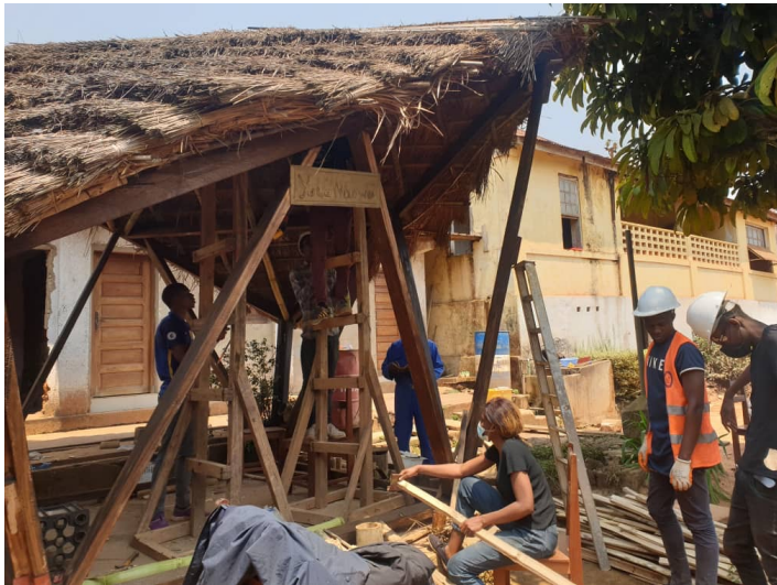
Ambiance des travaux sur chantier avec les différentes équipes.
