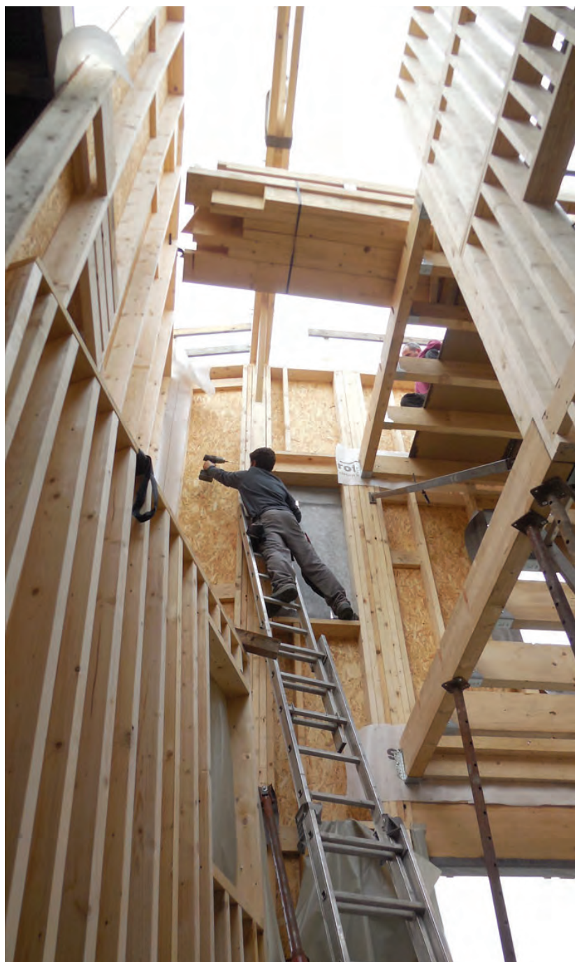
Maison T, en chantier 2016, Nantes - © TACT architectes
