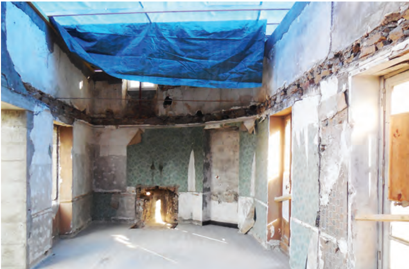
Maison T, en chantier 2016, Nantes - © TACT architectes
