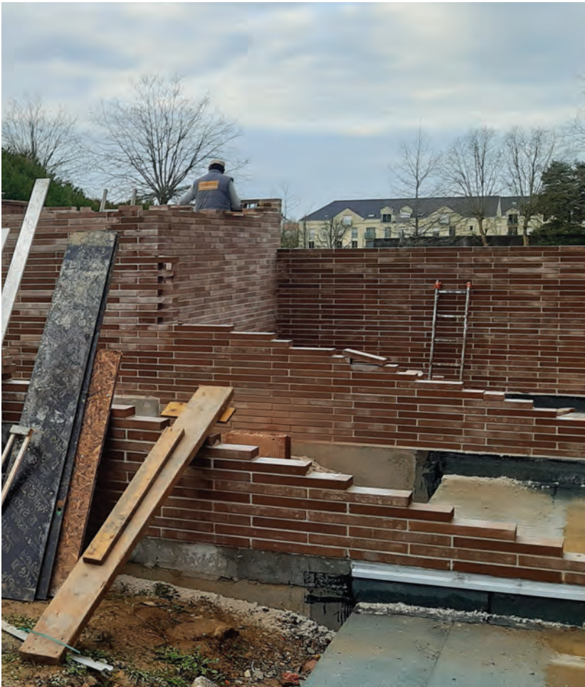
Logements Owen en Chantier à Nantes - © TACT architectes
